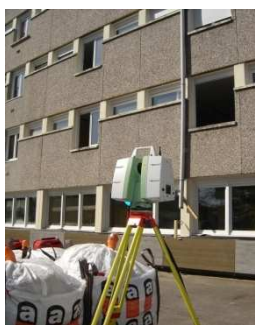
Relevé 3D de la façade par télémètre laser
