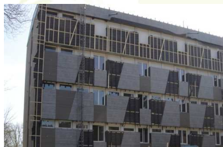
Réalisation du chantier par l'entreprise
